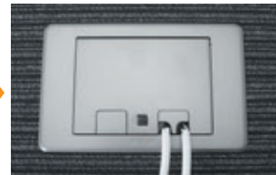
4 通線チップをプレートに差し込み、プレートを閉める。
