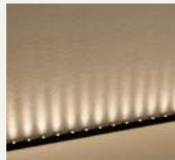
近すぎる距離で設置
