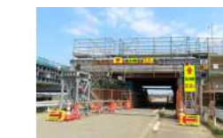
道路工事注意・建設工事注意
