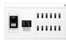
既設ホーム分電盤
