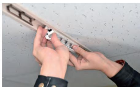
直付レール同梱タイプの場合、すでにレールに取付金具が装着されていますので、レールを市販のネジで固定し、その後、灯具をはめ込みます。
