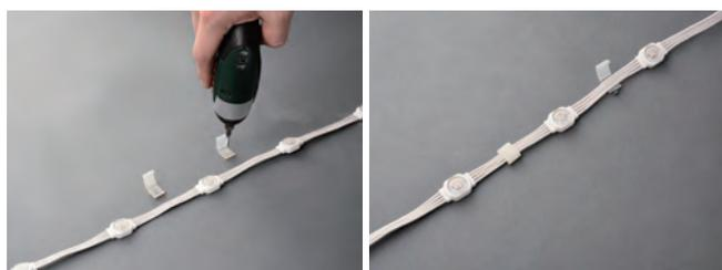
コードクランプを使うことでより狭い箇所への取り付けが可能です。最小施工寸法を守りつつご使用ください。(P.167に最小施工寸法記載)
